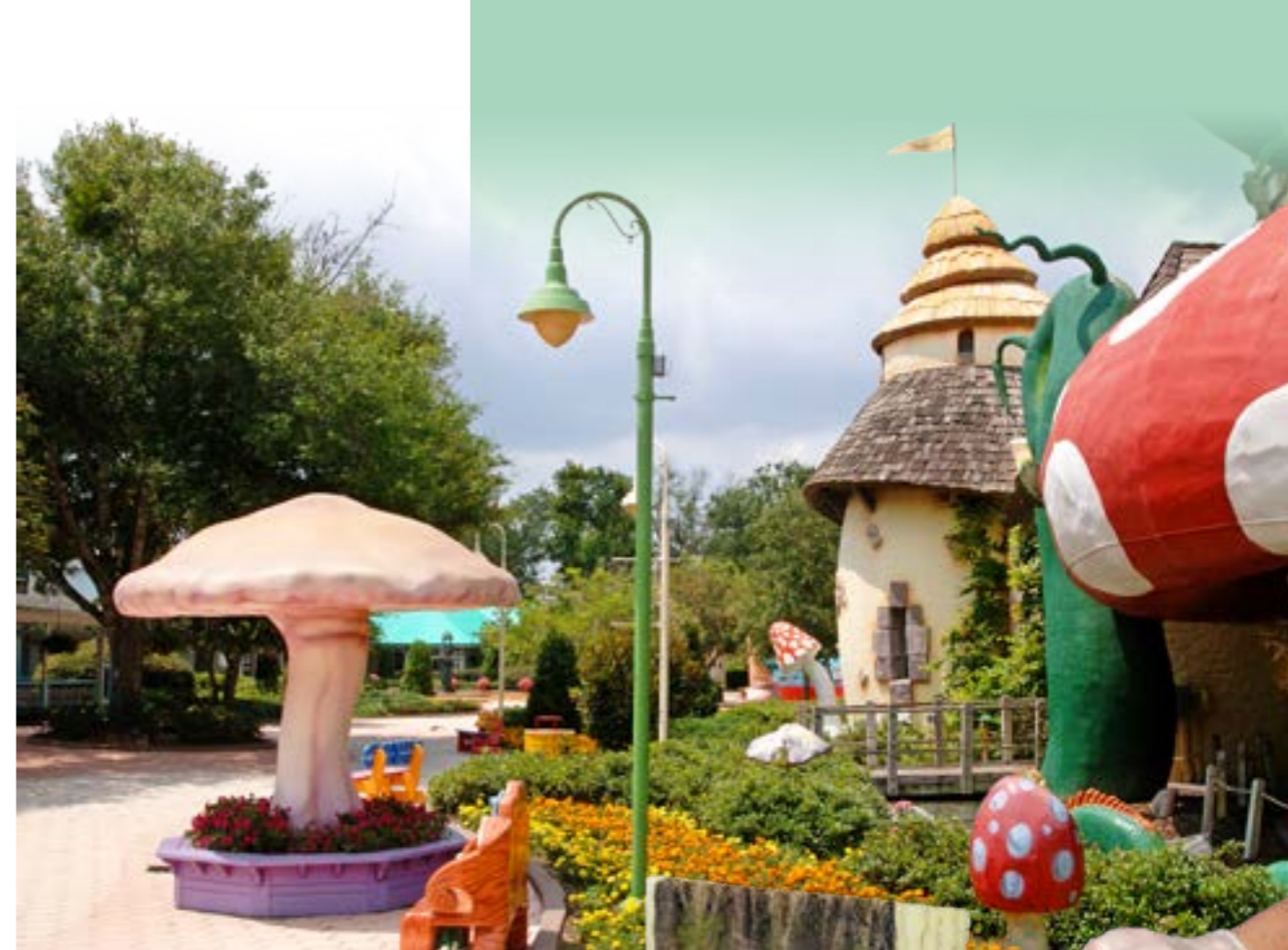
Strutture in polistirolo ricoperte con la resina epossidica Epsilon Pro e Habitat Cast N coat e Free Form Habitat Fire Safe .
