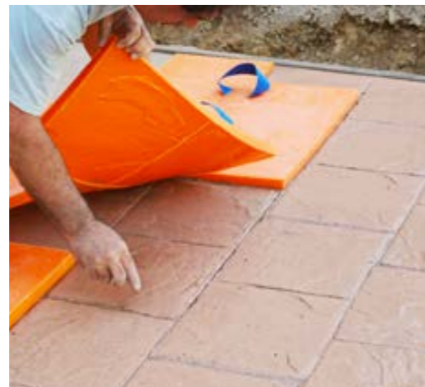
Stampi a pressione realizzati con gomma poliuretatica Vytaflex 60 , per imprimere una texture alla gettata in cemento.
